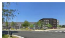
ACTIPARC DES VALETS Montluel
