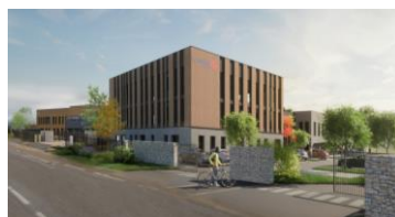
MIXTE Saint-Priest, 69800 2 500 m 2 de bâtiment
