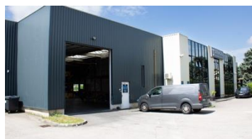
ACTIVITÉ Genas, 69740 3 900 m 2 de bâtiment
